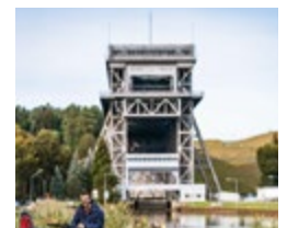
Das alte Schiffshebwerk in Niederfinow überwindet einen Höhenunterschied von 36 Metern (oben)
