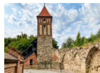
Historische Stadtmauer mit Wehrturm
